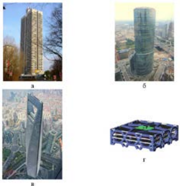
Рис. 1. Конструктивные решения небоскребов: а — бескаркасная; б — рамно-связевая схема; в — системы с мега-колоннами; г — система «HexaGrid»
