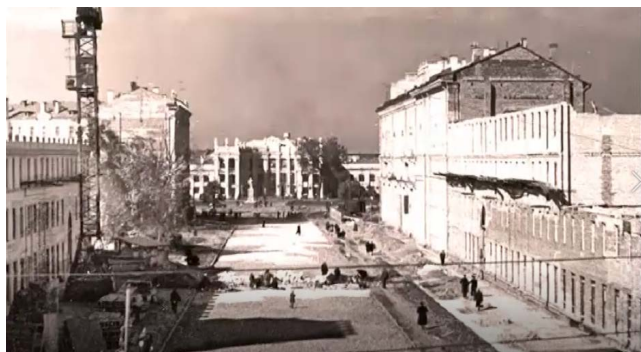
Рис. 9. Строительство ул. Мира (архитекторы: Л.В. Руднев, В.С.Левицкий; Ю.В. Львов.)
