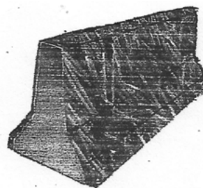
Рис. 6. Отбойник, покрытый ковром искусственной травы. Крепежные элементы не показаны
