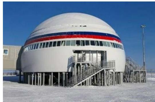
**Рис. 1. а) Антарктическая станция «Принцесса Елизавета», управляемая Бельгией; б) «Арктический трилистник», образец свайного фундамента и опор над землей**
